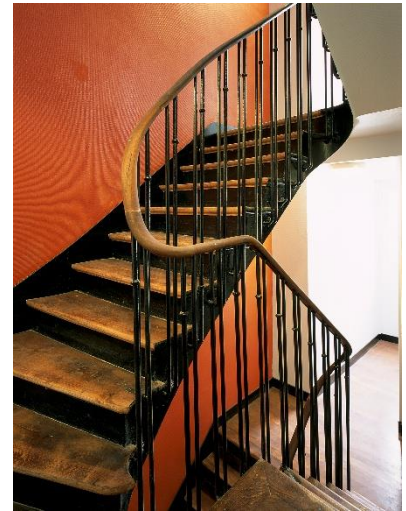
Rue Compans 75019 ◀ Avant et après ▶
